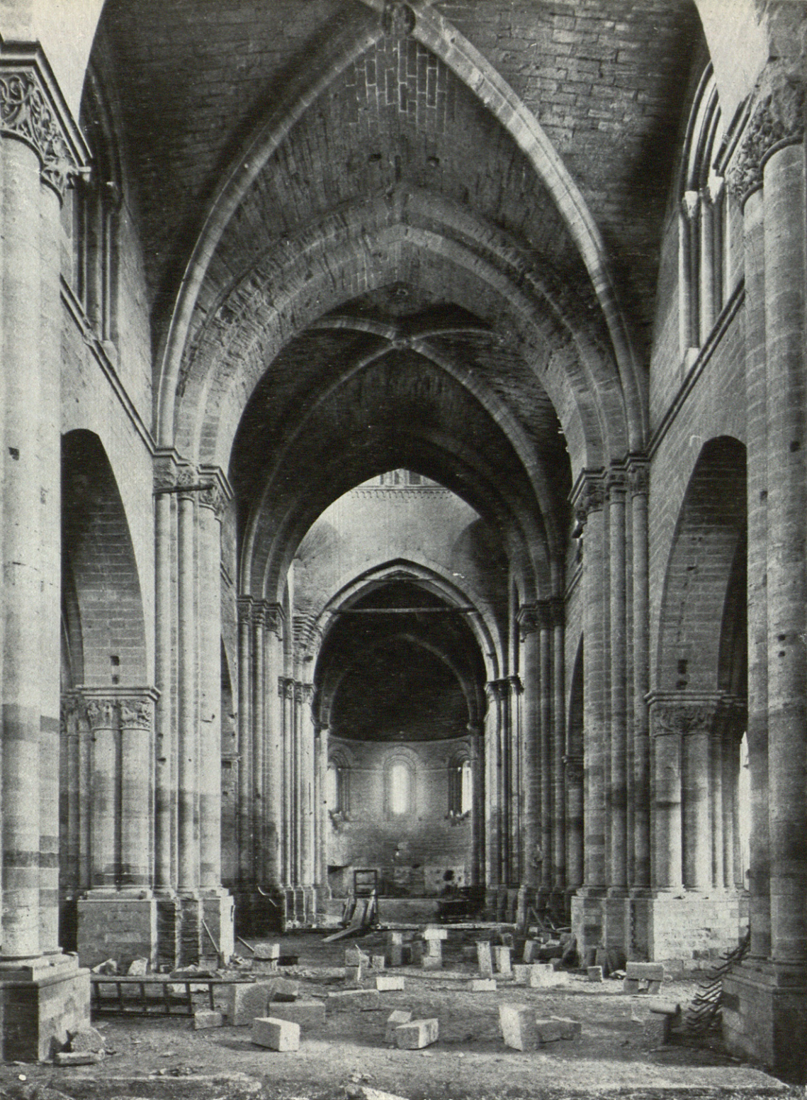
CATEDRAL VIEJA de Lé- rida. La nave central duran- te las obras.
