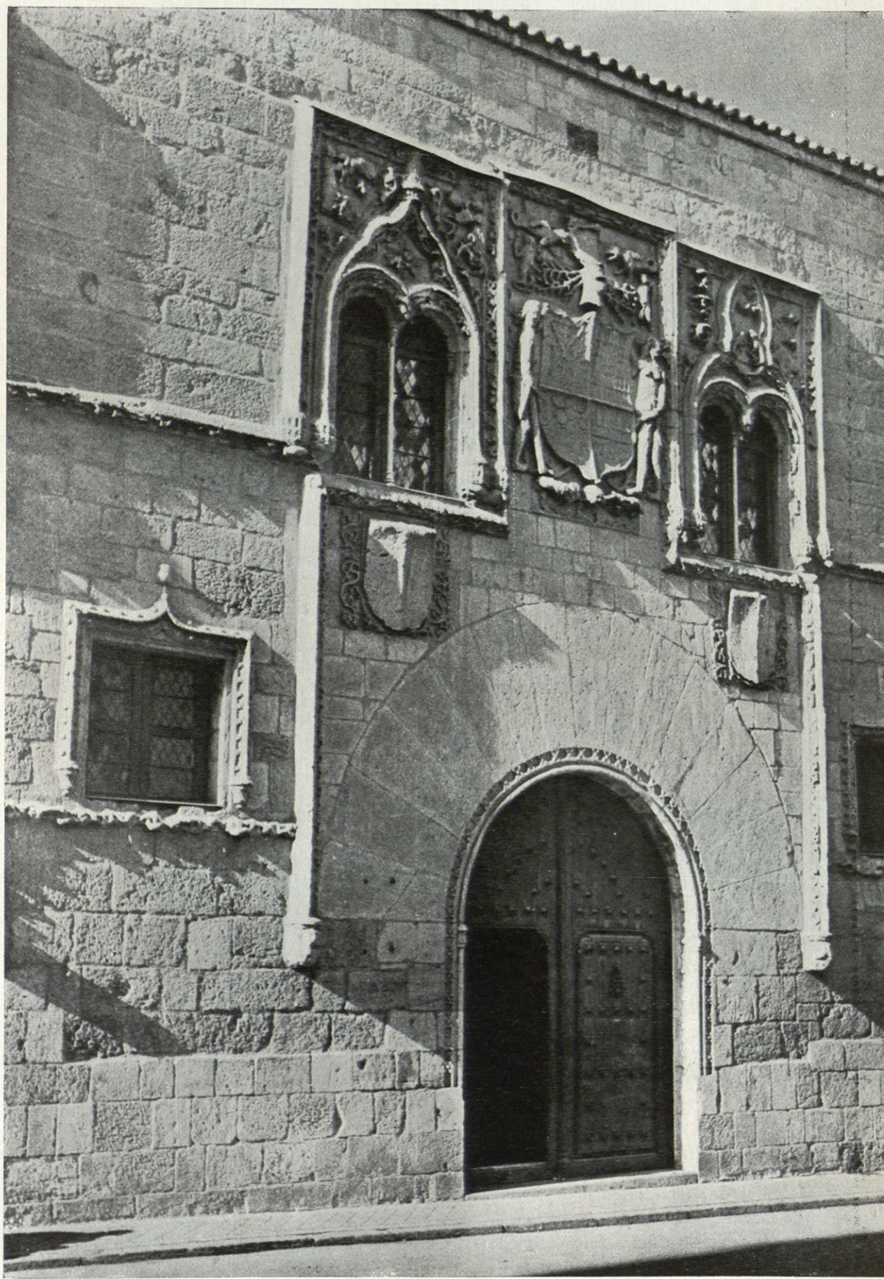
Zamora.—PALACIO DE LOS MOMOS. Detalle de la fachada, restaurada.
